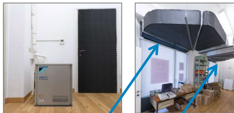
Canali di mandata e ripresa coibentati (prevalenza dei ventilatori da 60 a 150 Pa)
